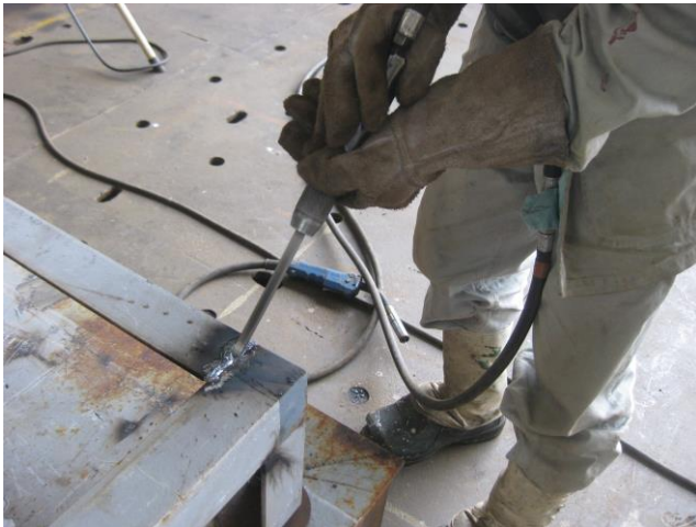
Pekerjaan membersihkan flag las pakai chipper
