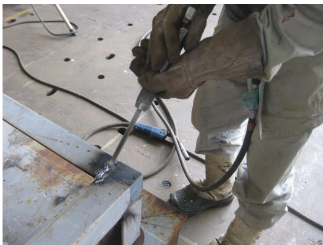
用风铲消除溶接残渣的作业
