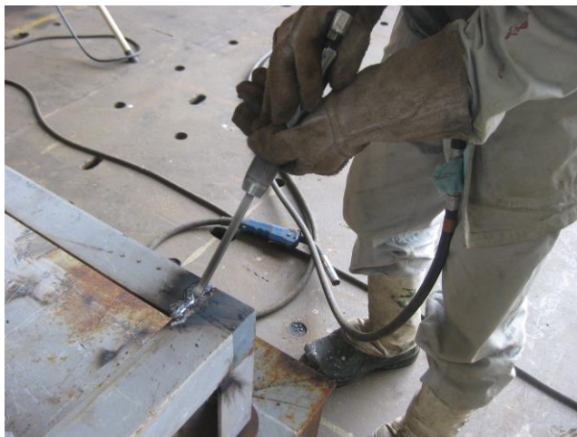
チッパーでの溶接スラグ除去作業
