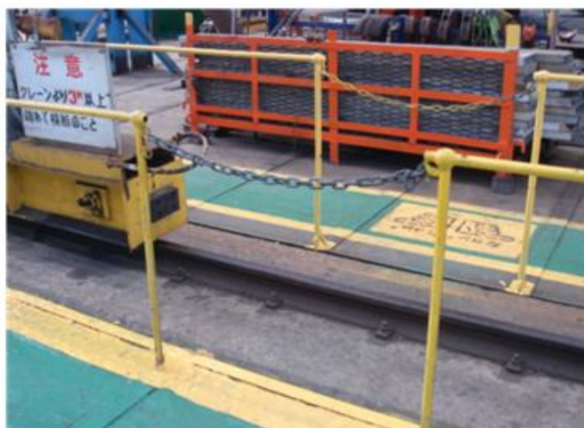
クレーン走行域への進入防止柵
