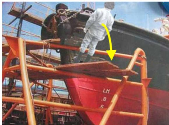
船首部の船体吊り金具を交換中、手摺りのない足場上から2.5m下の船台上へ墜落した
