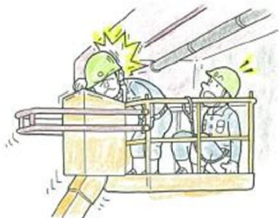
高所作業車で移動中、操作を誤り、ブリッジ張り出し部のカーテンプレートと高所作業車の操作盤に首を挟まれた
