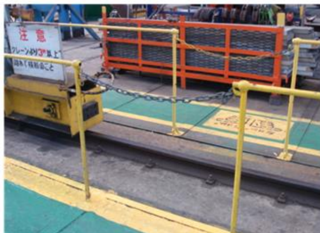
クレーン走行域への進入防止柵
