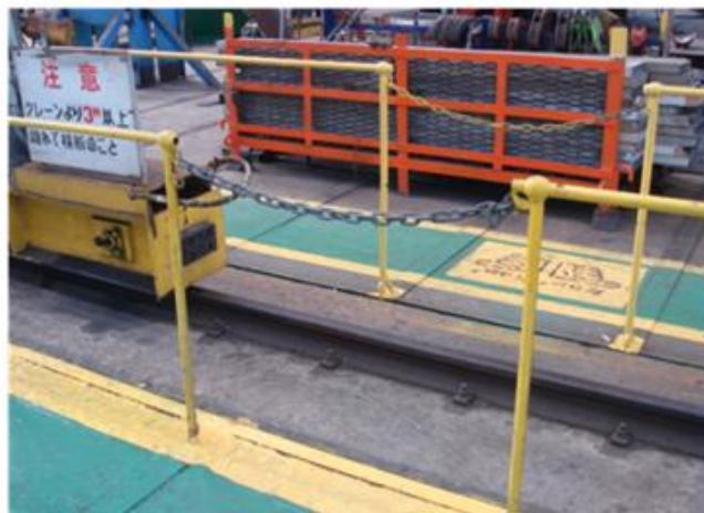
クレーン走行域への進入防止柵
