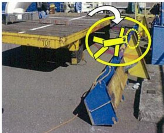
吊り天秤を台車に積み終え、シャックルを外し、巻き上げた際、シャックルの一部が吊りピースに引っ掛けかり、天秤とともに作業者が台車上から転落、下敷きとなった
