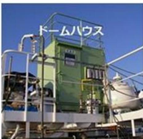
LNGタンク冷却試験中、安全弁の不具合により、ドームハウス（異物侵入防止用の仮設小屋）に窒素ガスが流入していた状態で、ドームハウスに入ろうとした時に窒素ガスを吸込み、瞬時に酸欠死
