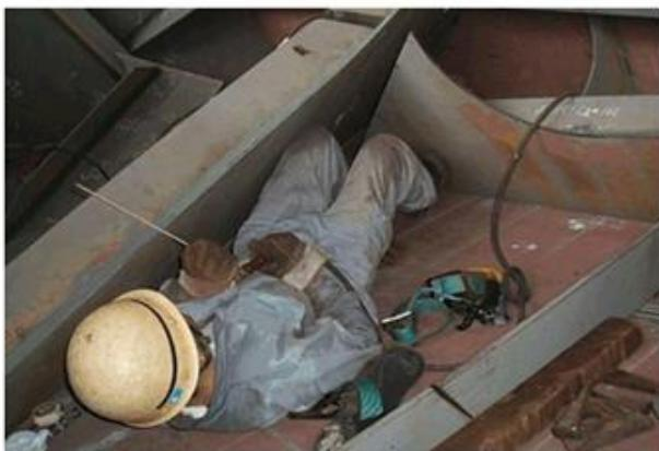
電撃防止装置不良のアーク溶接機を使用して、部材の仮付け作業中、溶接棒の交換時に感電した
