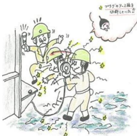
雨水の溜まったピットで電動グラインダー(100v)を使用してショットブラスト装置のビスを切断中、電源プラグに付いていたブラストの鉄球を通して電気が流れ感電した
