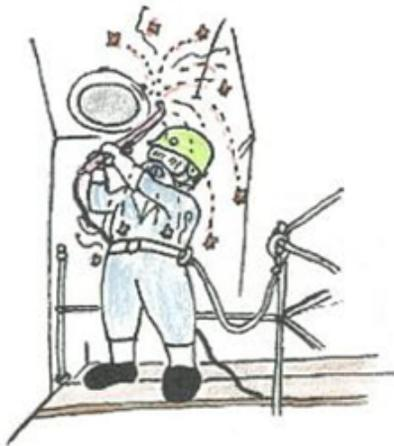
デッキ裏の足場上で貫通パイプの仮付け部を上向きでガス流しをしている時、火の粉により作業服が燃え、胸部及び背中を火傷した
