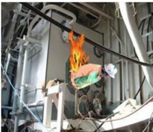
狭いタンク内で艤装品仮付け作業中、ガス切断機の酸素が漏れていたため、溶接の火花で作業服に引火し、一気に燃え上がった
