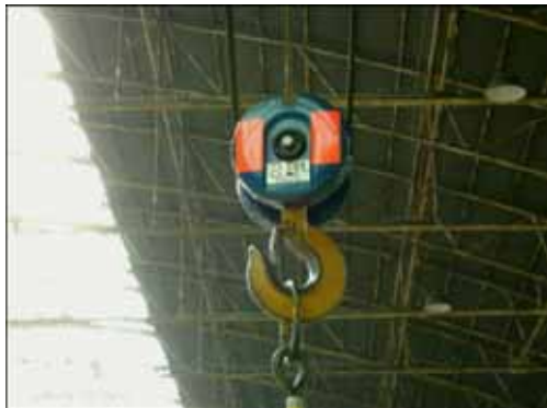
PCクレーンにも、蛍光のオレンジテープを貼り付けた。
