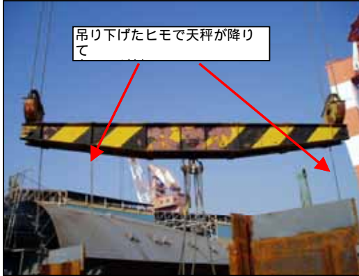
(クレーン玉掛け作業)
