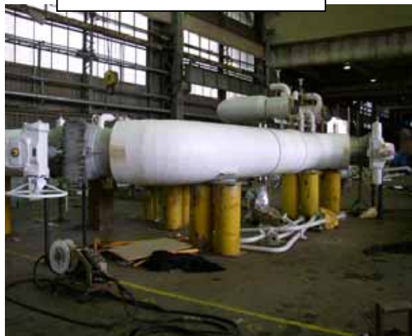
改善後: 継手部溶接を低所化
