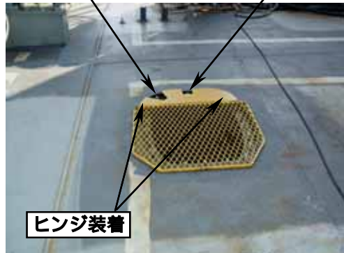
(マンホール開口部転落落下防止用カバー)
