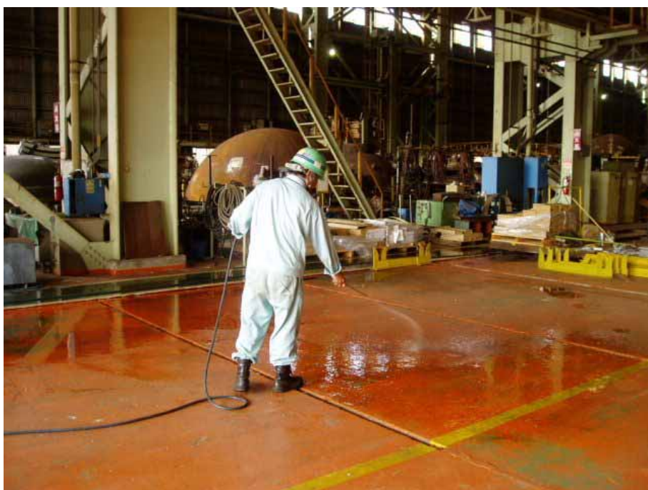
（作業場の水撒き）
