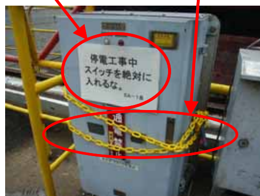
(陸上供給電源投入禁止表示及びスイッチ投入禁止治具)
