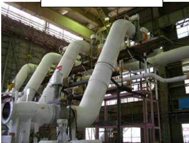
改善前: 全ての作業が高所作業
