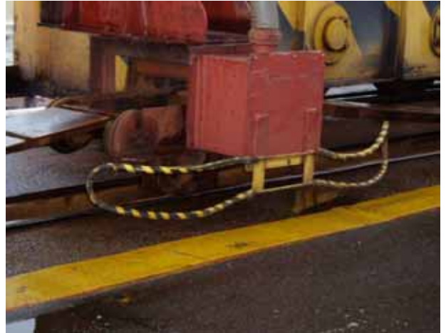
(ハンマーヘッドクレーン足元ガード)
