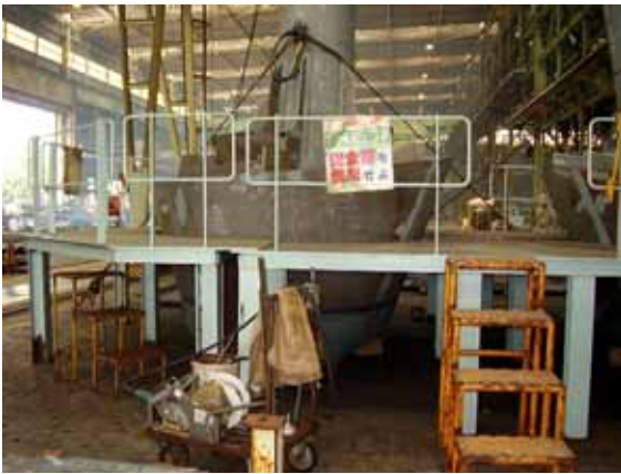
(ボルスタ-専用ユニット足場)
