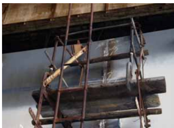
(引っ掛け足場)
