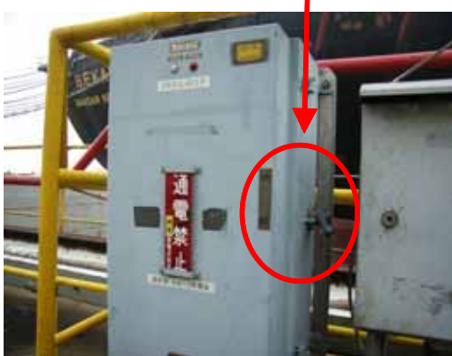
(陸上供給電源投入禁止表示及びスイッチ投入禁止治具)
