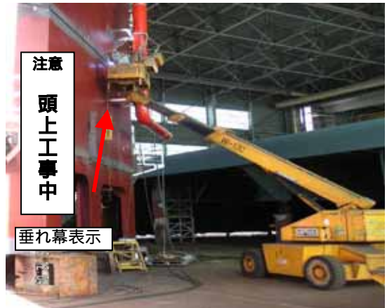
(高所作業立ち入り禁止表示)
