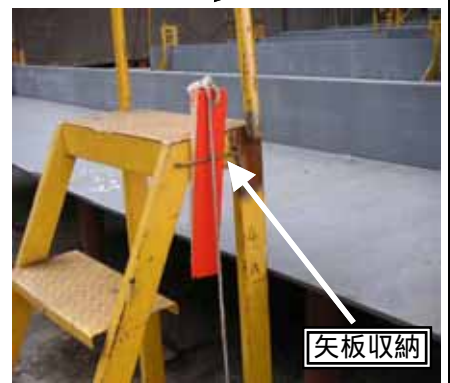
使用しない折は、昇降階段に矢板を収納する
