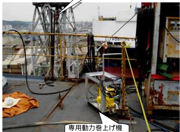
(外板 S E G 溶接作業における治工具類の落下防止専用巻上げ機)
