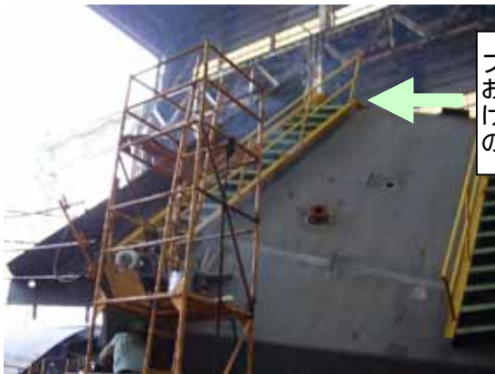
(傾斜ブロック専用昇降治具)
