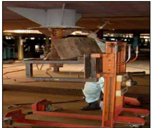
(専用治具によるブロック裏面付部材持ち上げ)
