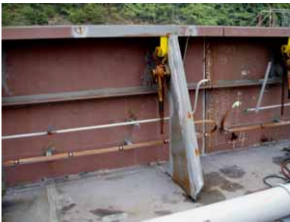
(専用治具によるハッチコーミング取付作業)
