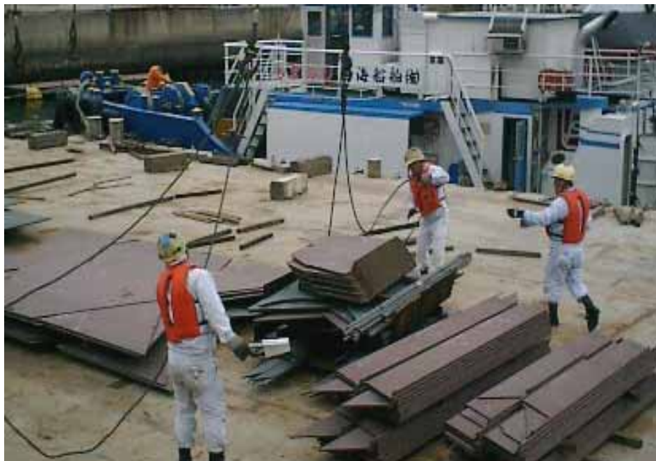
台船への加工部材の積み込み
