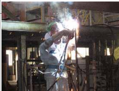
①溶接作業中
