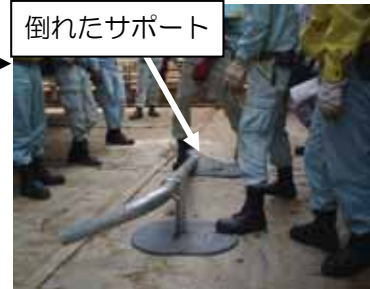
②配管に足を掛け体重を掛けたら、サポートが一瞬に倒れ、転倒しそうになった。艀装中のブロック等の中では、災害になる。
