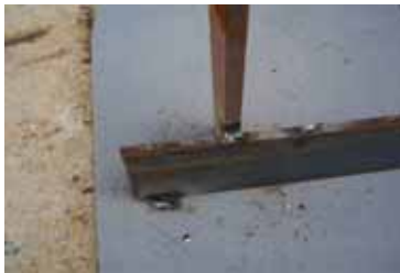
①手摺支柱1本で1点の仮付け溶接（5mm程度）
