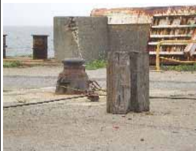
①滑車などを使って、「への字」に係船索を展張する。内側に木材を置く。
