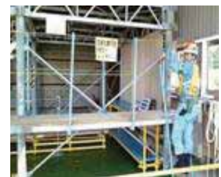
④ 足場歩行体感 (梯子固縛状況確認 等)
