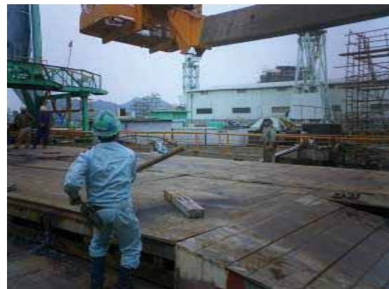
②丸太を外す。ブームが上下に激しく振れる
