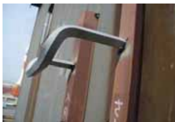
①ステップの仮付け溶接 (2点、5mm程度)
