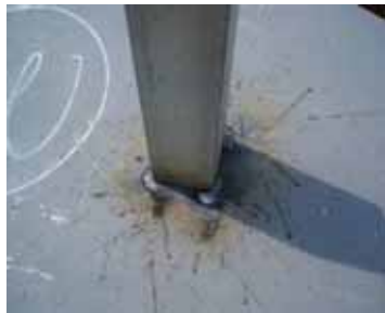
①サポートの仮付け溶接 (2点、5mm程度)
