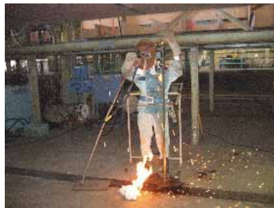
②下面の可燃物が燃え、胸ポケットのライターに引火
