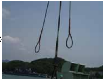
少し（約30cm）吊り上げただけで、遊びのワイヤー2本が回転した（荷もゆっくり回転する）
