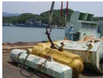
①2本とも同じ（Zヨリ）で、1点吊りの準備完了
