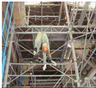
⑩ 墜落演練(ダミー人形) (高さ6mからの落下)
