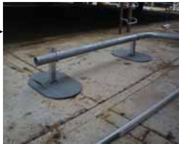
②配管に足を掛け体重を掛けたら、サポートが一瞬に倒れ、転倒しそうになった。艀装中のブロック等の中では、災害になる。
