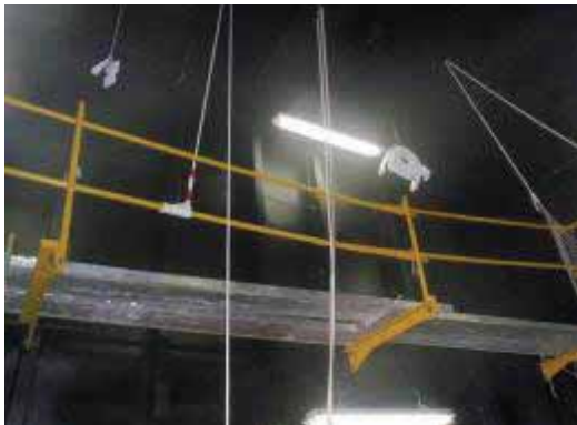
天井に吊ったピース
