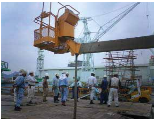
①ブームの下に丸太を立て、ブーム下げ操作でテンションを掛ける
